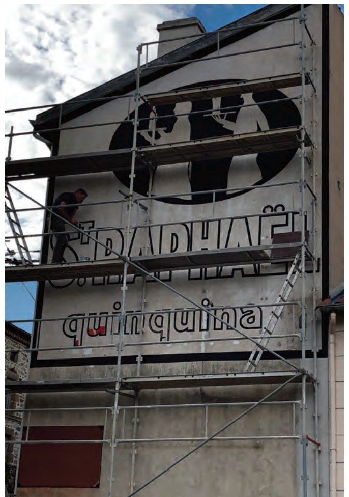
APRÈS REPÉRAGE LETTRAGE ET DES FORMES, APPLICATION D'UN FIXATEUR
