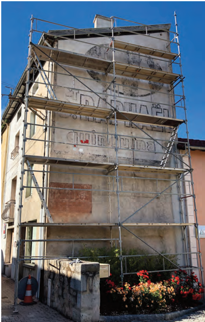
ÉCHAFAUDAGE, BROSSAGE, REPÉRAGE DU LETTRAGE ET DES FORMES
