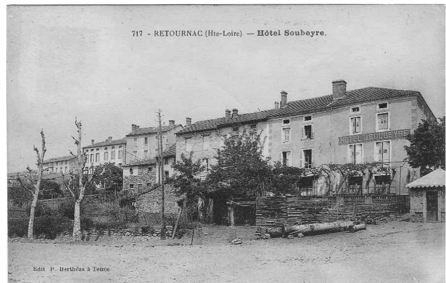
... et les maisons toutes tournées au sud et vers la Loire pour mieux bénéficier de la vue et de la chaleur du soleil...
